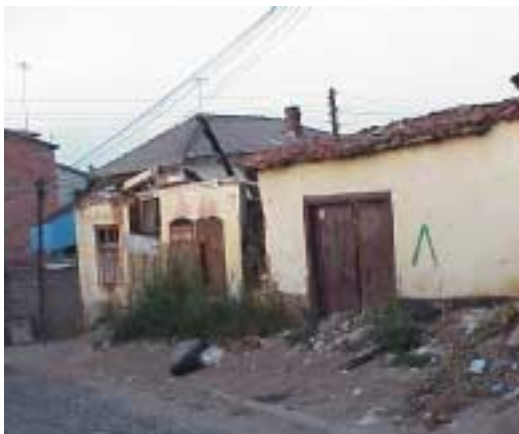
zerstörtes Haus einer serbischen Familie che und ein kleines Badezimmer ein-
